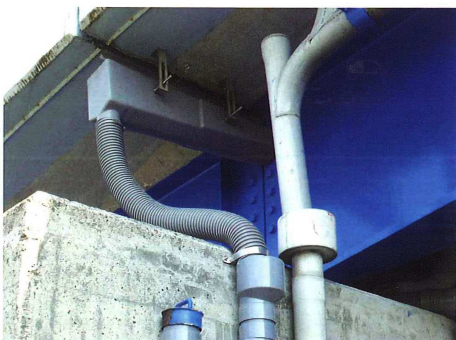
地覆部への設置 (橋脚用1V)
