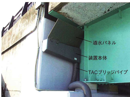
地覆部への設置 (橋台用1V-DT)
