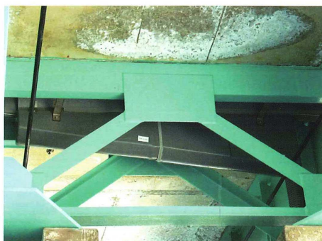
桁間への設置 (橋脚用2V-DT)
